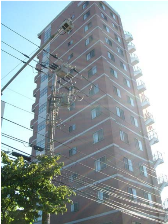
●外観（北側より撮影）
