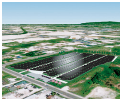
メガソーラー施設「土屋ソーラーファクトリー札幌」
