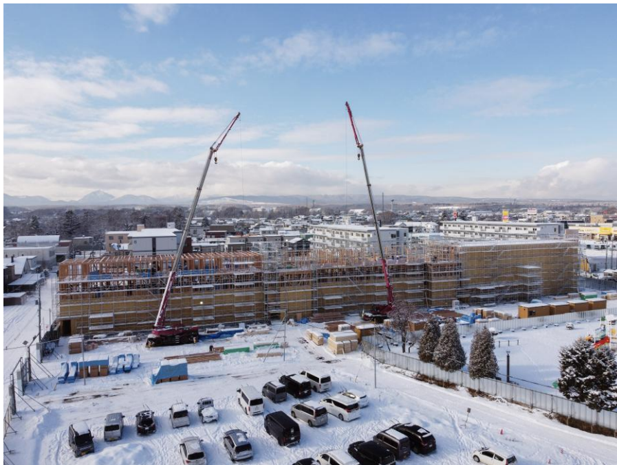
木造4階建て集合住宅 「恵庭市営住宅恵央団地」
